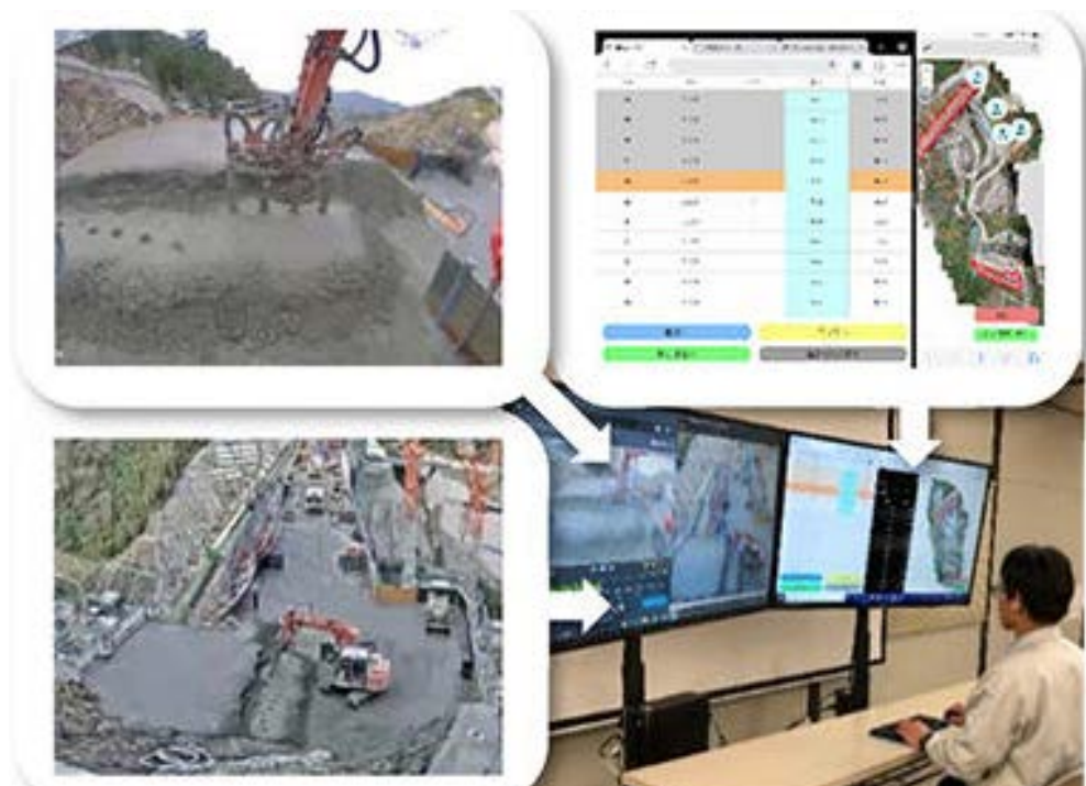
圖 3、遠端管理混凝土灌漿狀態 [2]
