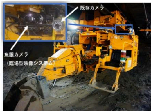
図2 本システム設置掘削機
